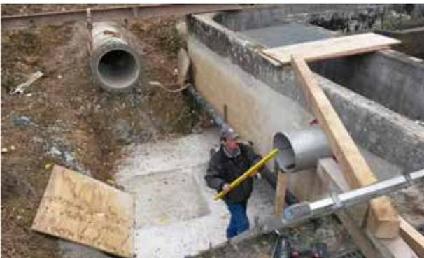
Rechts: Kreislaufschlammleitung; oben: Leitung zur vorgelagerten DN-Zone
