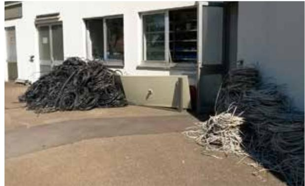
Angefallene alte Kabel aus dem Umbau der NSHV Biologie
