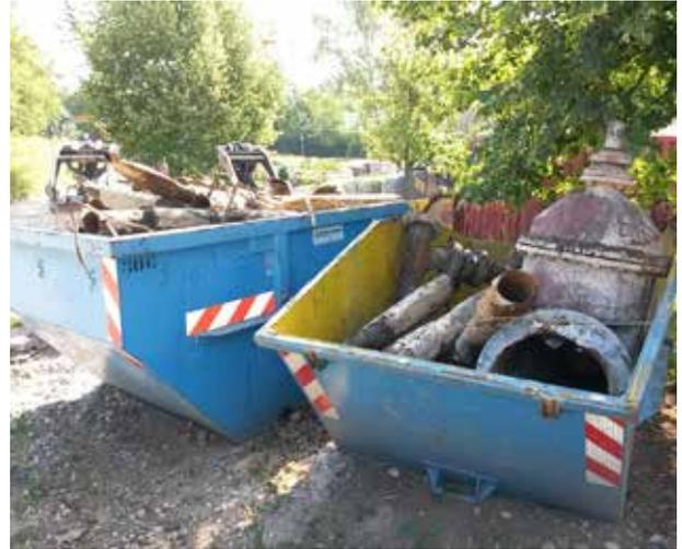
Ausgebaute alte Schlammleitungen und Schieber
