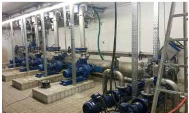
*Neu installierte Rücklaufschlamm- und Überschussschlammumpen vor dem Elektro-Anschluss*
