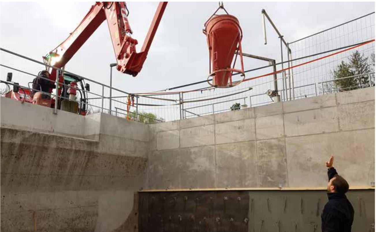
Einbau des Profilbetons im RÜB auf der Kläranlage Wolfschlugen
