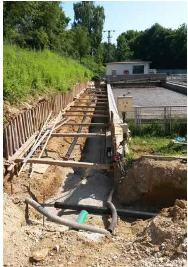
Beginn der Verlegung der 700er Rücklaufschlamm- und 150er Primärschlammleitung
