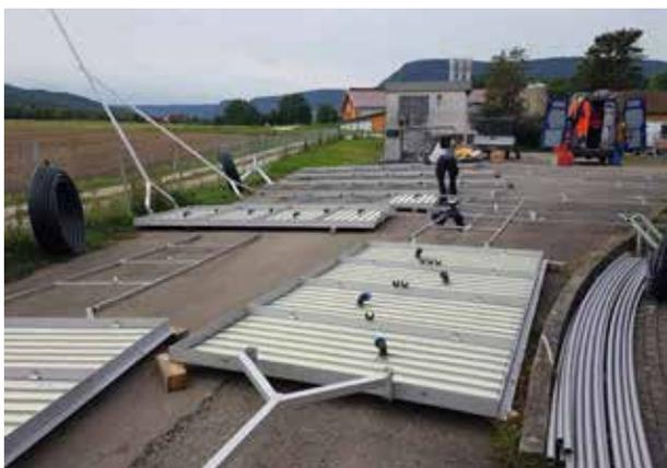
Vormontagearbeiten an den Plattenbelüftern fürs Rundbecken
