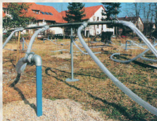
Bodensanierung in einem Wohngebiet
