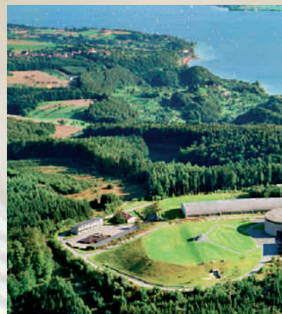
Wasserwerk der Bodensee-Wasserversorgung auf dem Sipplinger Berg (BWV)
