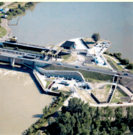
Abb. in Reihe von oben: - Hochwasserrückhaltebecken Erzgrube-Nagoldtalsperre/Altensteig - Kulturwehr Kehl/Straßburg - Umgestaltung der alten Rench im Sommer 2002 - Untere Rappenwörth-Schließe bei Karlsruhe - Schleuse Iffezheim
