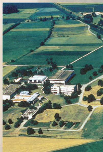
Landeswasserversorgung in Langenau (LW)
